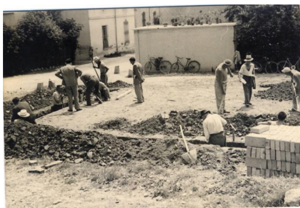
L'inizio dei lavori per la costruzione della nuova Casa del Popolo
