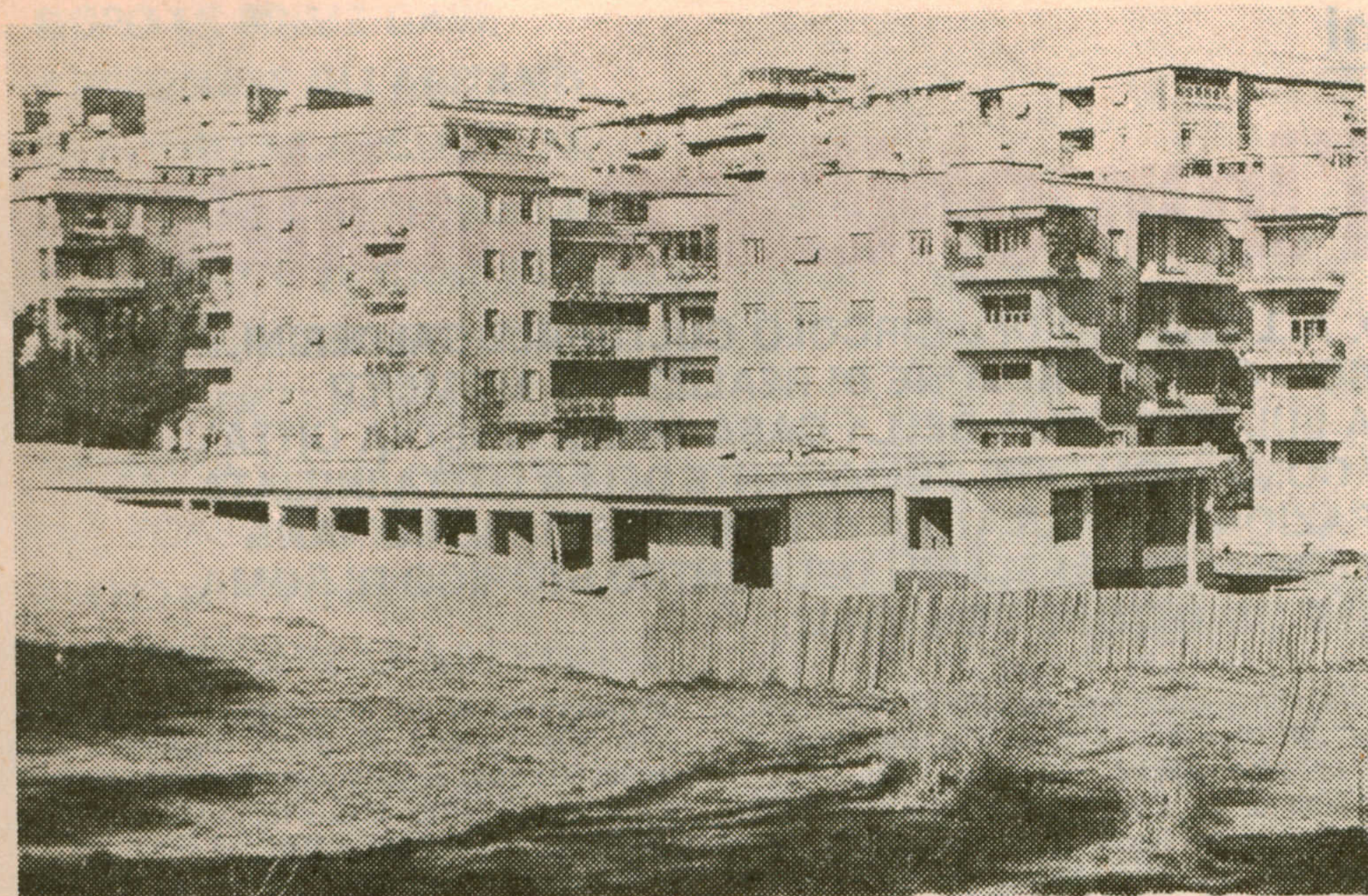
Nella foto: l'asilo di Villa Chigi i cui lavori sono stati bloccati
